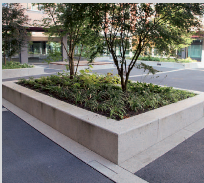
Esthétique épurée - caniveaux à peine visible
