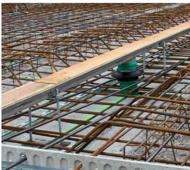
Mise en place du monobéton grâce à des supports de pose stables
