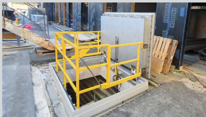
Acciaio inox, riempimento con calcestruzzo in fabbrica, E600, apertura con sistema idraulico, ringhiera automatica, a tenuta stagna, resistenza al fuoco EI60, isolamento per ridurre la condensa
