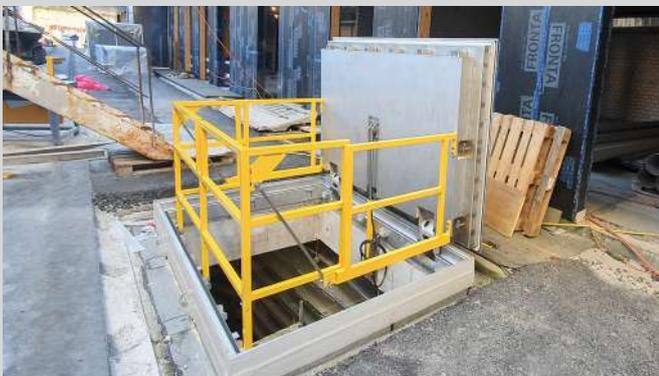
Edelstahl, werkseitige Betonfüllung, E600, aufklappbar mit Hydraulik, automatisches Geländer, wasserdicht, Feuerwiderstand EI60, Isolation zur Verminderung von Kondenswasser
