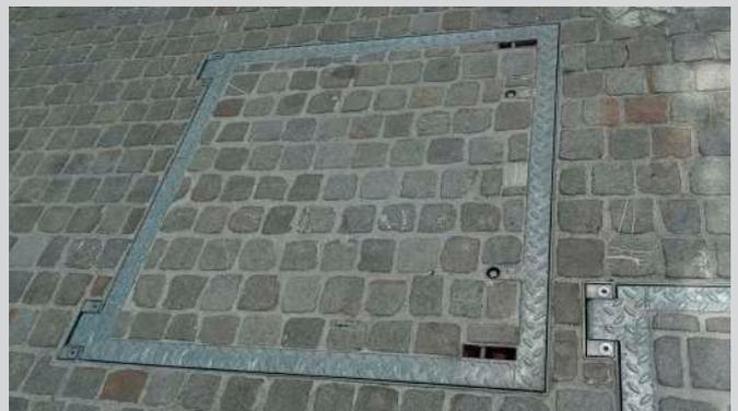
Stahl feuerverzinkt, auspflasterbar, C250, aufklappbar mit Öffnungshilfe, wasserdicht
