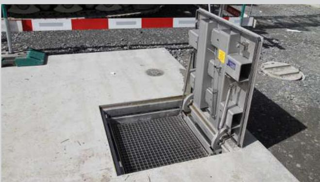
Edelstahl, Tränenblechoberfläche, D400, aufklappbar mit Öffnungshilfe, Absturzsicherung, verriegelt, wasserdicht
