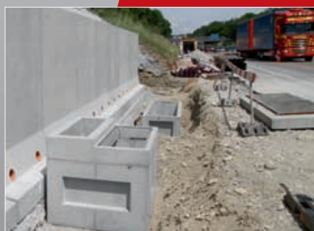
Recouvrement de surface avec puits de câbles en béton
