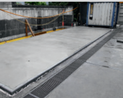
Coperchi in acciaio zincato con riempimento in calcestruzzo, classe D400, 2 sezioni. Apertura 300 x 1100 cm.
